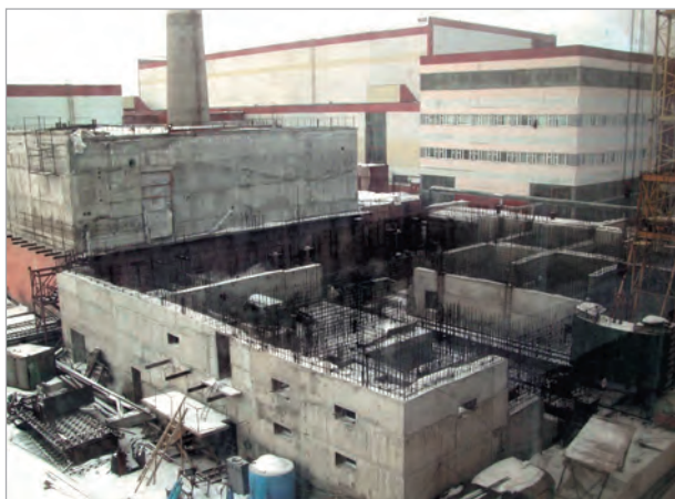
Рис. 2. Сооружение КП ЖРО
