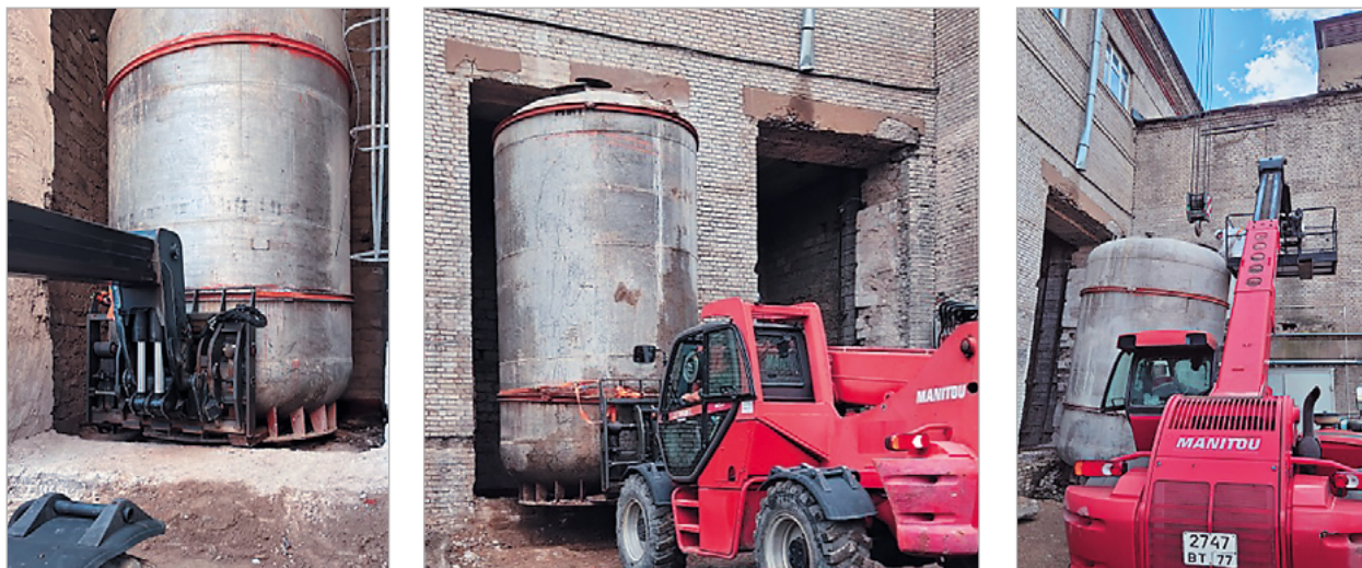
Рис. 3. Демонтаж отстойников через проем
