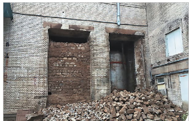
Рис. 2. Организация проемов в стене на северной стороне здания
