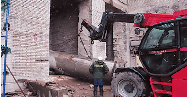
Рис. 5. Демонтаж фильтр-колонн
