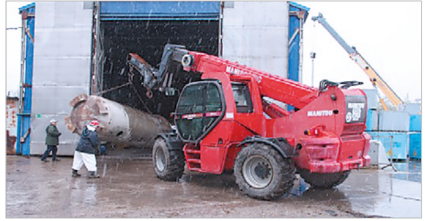
Рис. 5. Демонтаж фильтр-колонн
