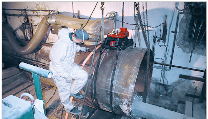
Рис. 7. Демонтаж и фрагментация монжусов
