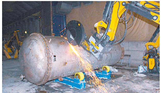
Рис. 6. Фрагментация фильтр-колонн
