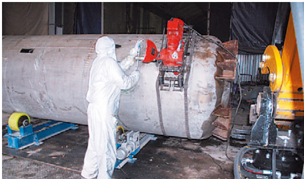
Рис. 6. Фрагментация фильтр-колонн
