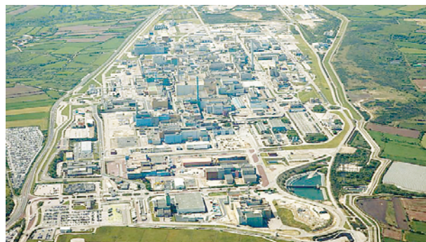
Рис. 7. Вид сверху на площадку завода Ла-Аг на севере Франции [7]
