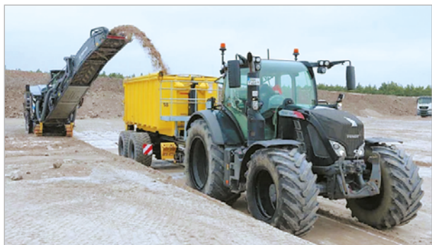
Рис. 2. Дорожная фреза послойно удаляет соляные породы с территории соляного отвала Горлебен и сбрасывает разрыхленную породу в контейнер, прицепленный к трактору [2]
