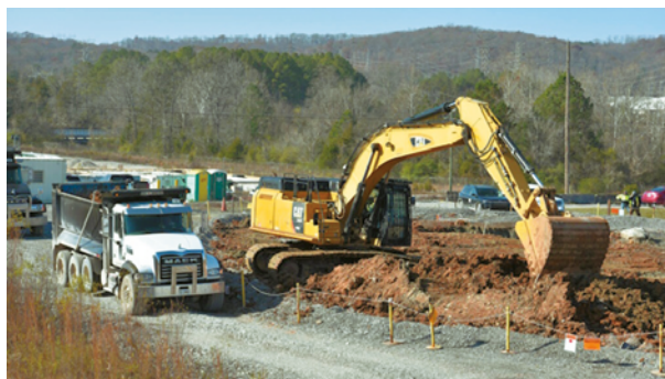
Рис. 6. Проведение работ по рекультивации грунта на площадке технологического парка Восточного Теннесси [7]
