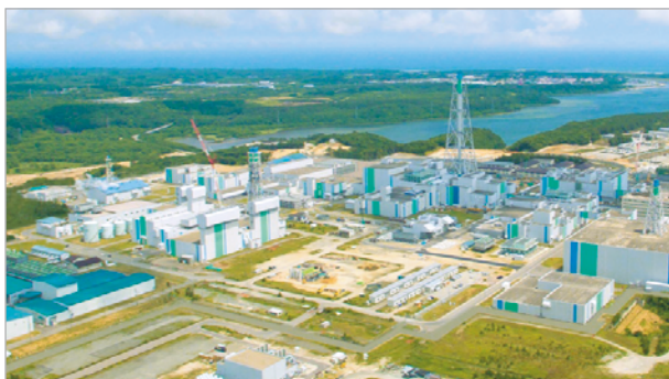
Рис. 4. Площадка строящегося завода по переработке ОЯТ и производству МОКС-топлива в Роккасё [5]
