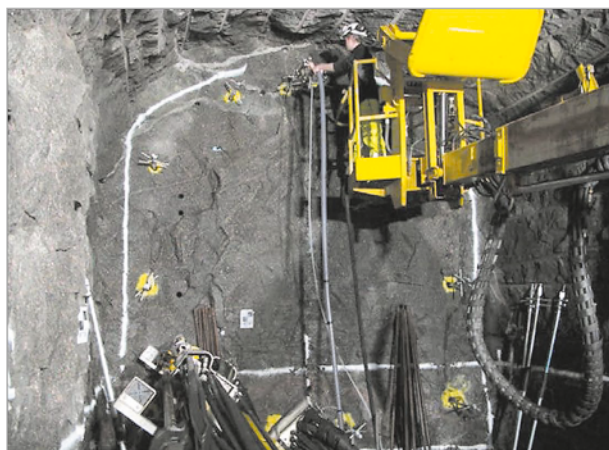
Рис. 5. Нагнетание упрочняющего состава в трещиноватые породы с помощью скважин для формирования в приконтурной части массива уплотненной зоны [22]
