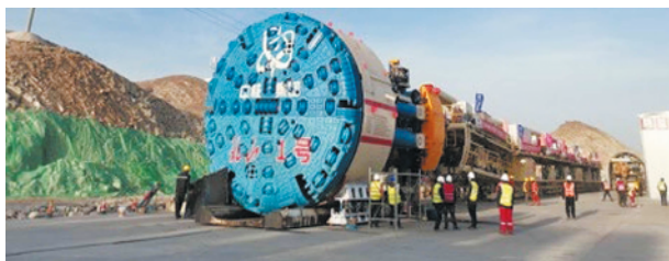
Рис. 11. Тоннелепроходческий комплекс Beishan №1 для прокладки тоннелей в скальных породах [29]
