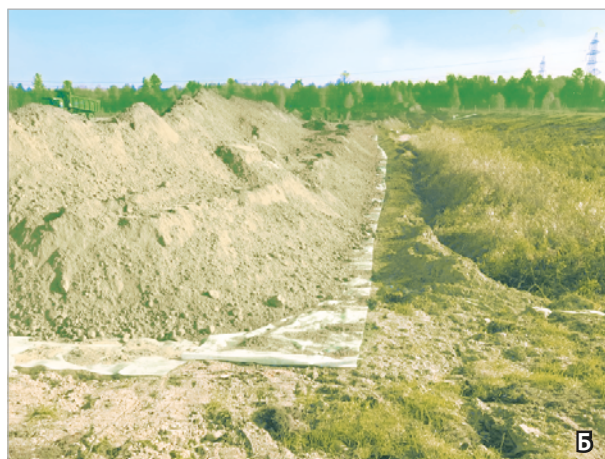
Рис. 2. Шламоотстойник технологических отходов: А — до консервации, 2022 г., Б — в процессе консервации, 2023 г.
