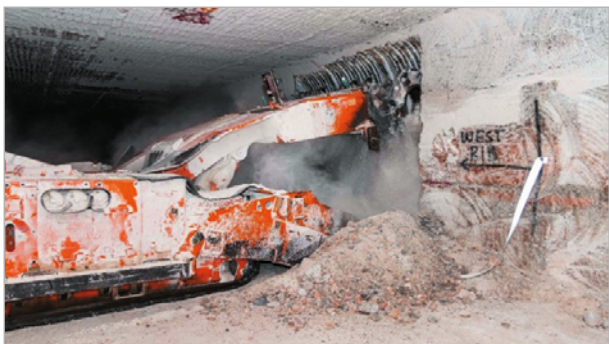
Рис. 4. Работы по проходке Секции № 11 ПГЗРО WIPP в штате Нью-Мексико (США) [6]
