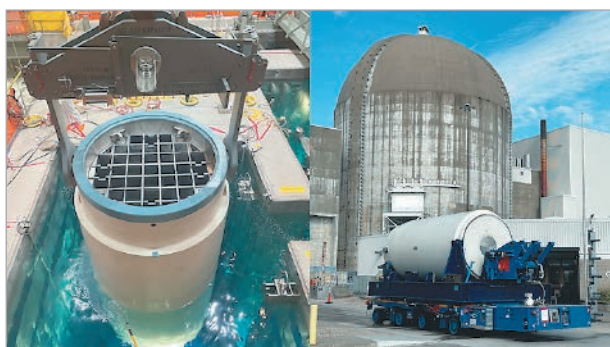
Рис. 6. Этапы передачи ОЯТ на хранение в модульной системе MATRIX [8]
