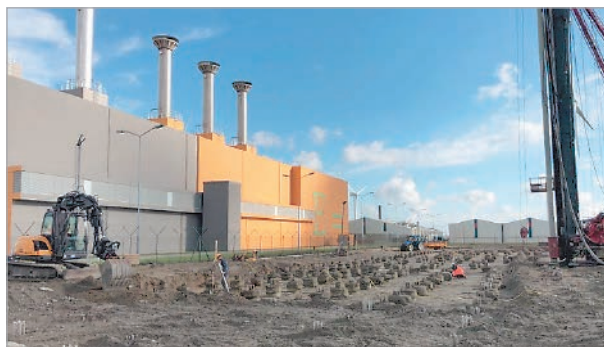
Рис. 3. Первые буровые сваи, установленные на площадке нового ПХ MOG в Борсселе [6]
