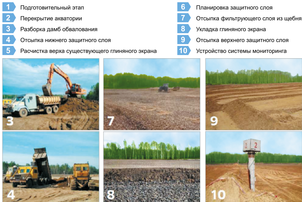
Рис. 2. Этапы консервации бассейнов размещения особых РАО АО «СХК» на примере Б-1 [27]
