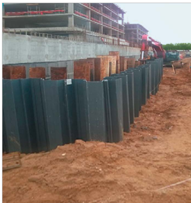
Рис. 5. Шпунтовая завеса из ПВХ (строительство объекта в Сколково)
