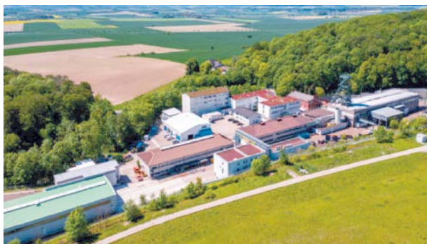
Рис. 1. Площадка бывшей соляной шахты Asse II, подземные выработки которой в прошлом использовались для захоронения РАО низкого и среднего уровней активности [2]
