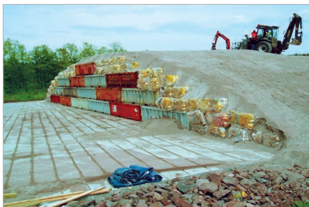
Рис. 1. Технология захоронения ОНРАО на площадке АЭС Oskarhamn (Швеция) в процессе возведения покрывающего экрана [27]
