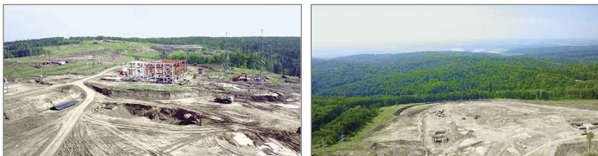
Рисунок 24 – Площадка строительства подземной исследовательской лаборатории в Нижнеканском массиве
