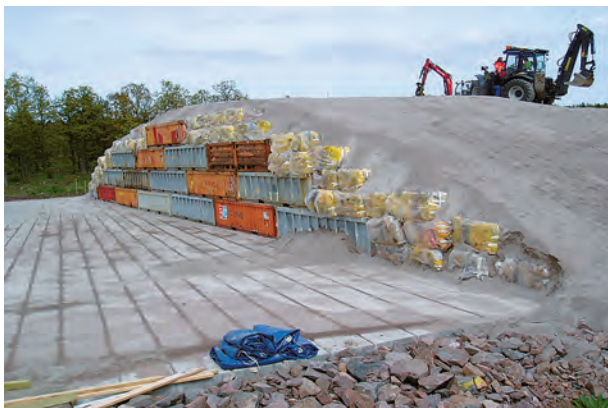
Рис. 1. Технология захоронения ОНАО на площадке АЭС Oskarhamn (Швеция) в процессе возведения покрывающего экрана [2]
