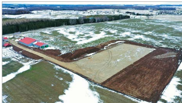
Рис. 1. Площадка, подготовленная для бурения скважины [2]
