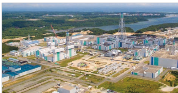
Рис. 6. Завод по переработке ОЯТ в Роккашо (Япония)
